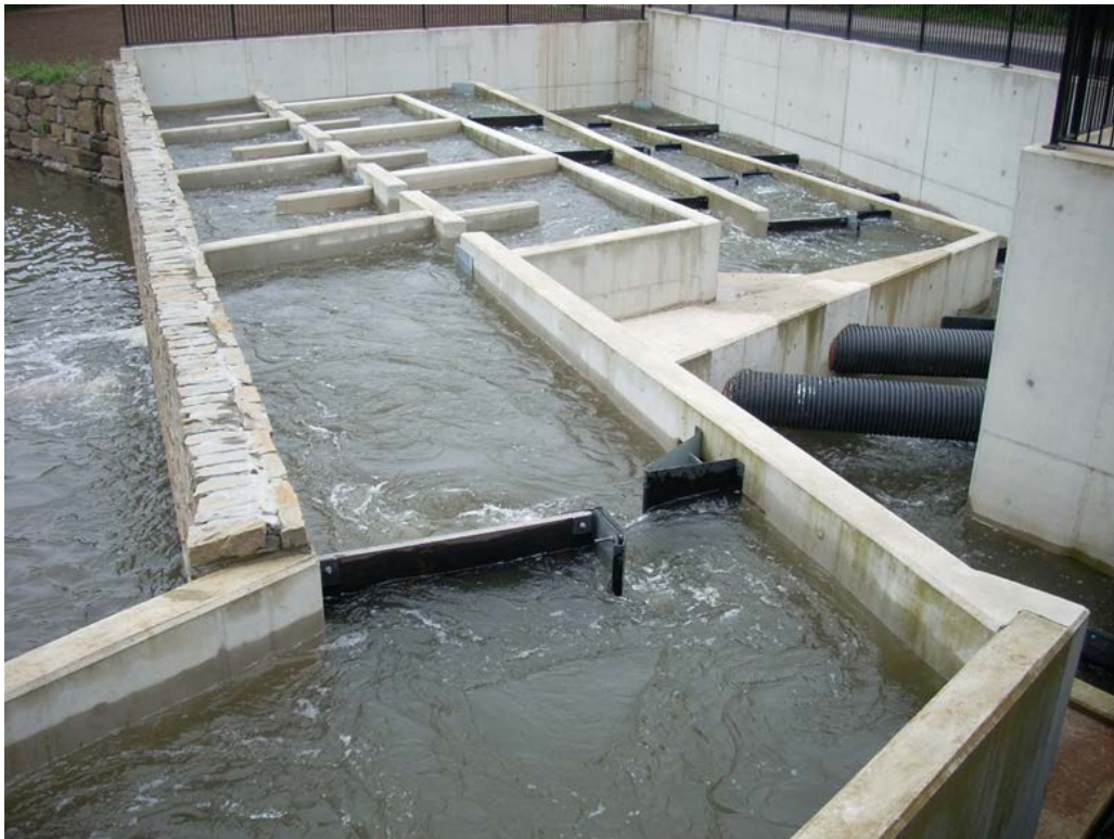
Foto 2: De vistrap bij de waterkrachtcentrale in Roermond (Nederland) (Foto: Johan Coeck)
