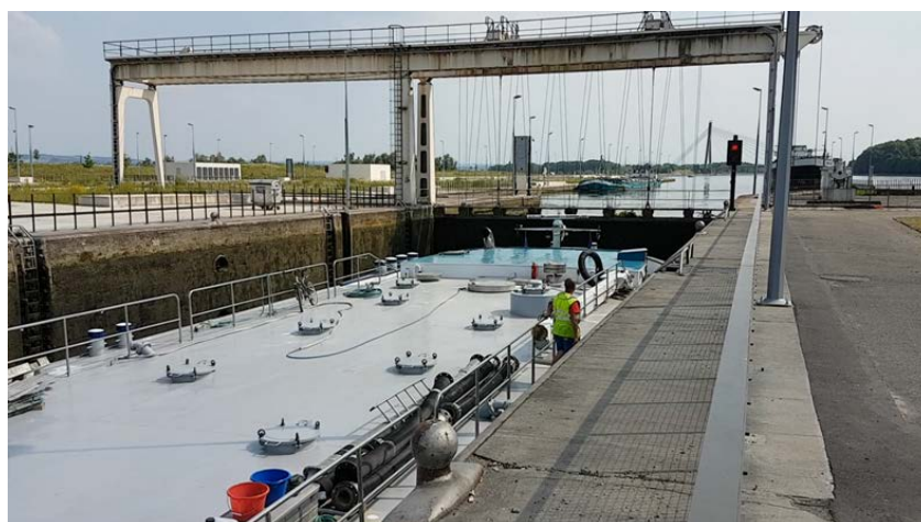
Photo 1 : L'écluse de Lanaye (Wallonie) (Photo : CIM)
