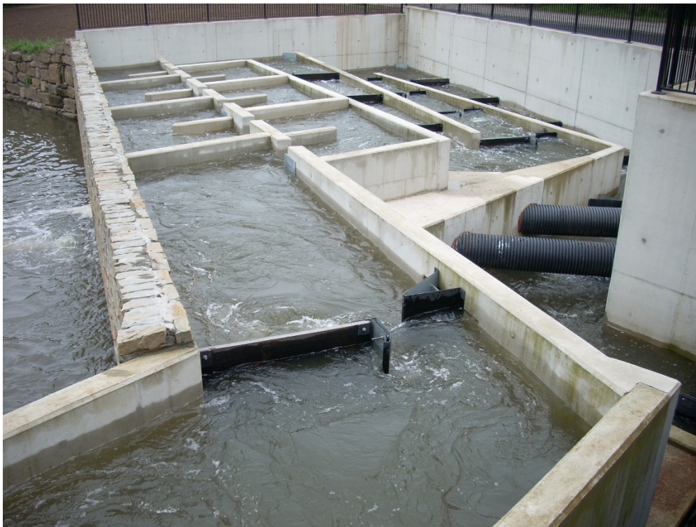
Photo 2 : La passe à poissons de la centrale hydroélectrique de Roermond (Pays-Bas) (Photo : Johan Coeck)
