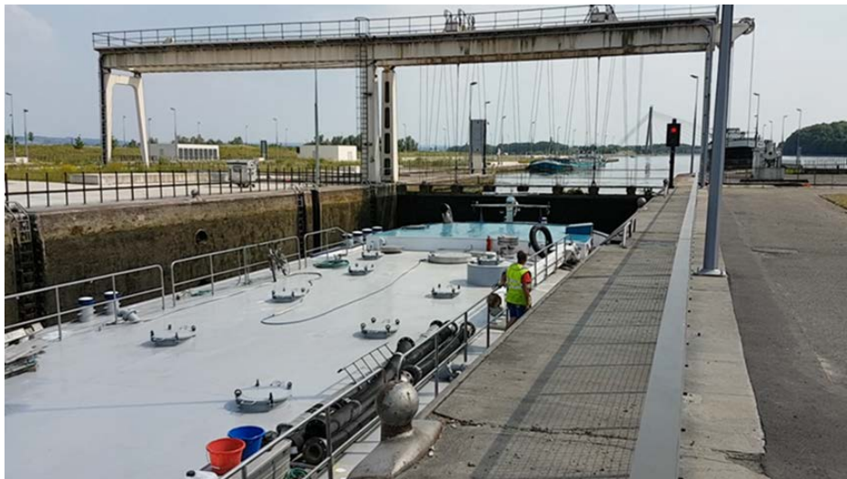
Foto 1: Die Schleuse von Lanaye (Wallonie) (Foto: IMK)
