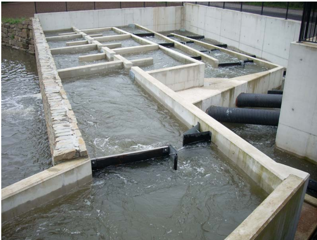
Foto 2: Der Fischpass am Wasserkraftwerks in Roermond (Niederlande) (Foto: Johan Coeck)
