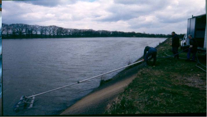
Foto 2: Plaatsing van vlotter en zuigkorf (bron: VMM)
