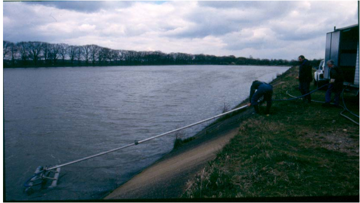
Photo 2: Le positionnement du flotteur et de la crépine d'aspiration. (Source : VMM)
