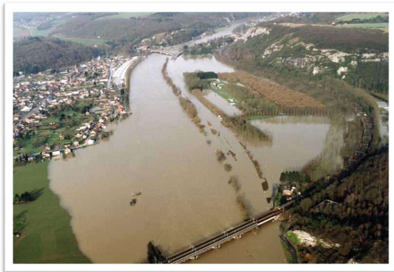
MAASHOCHWASSER OBERHALB VON DINANT
